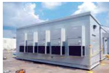
Фотография существующей системы управления насосной станцией, разработанной по специальным техническим требованиям на базе PumpSmart MV.
